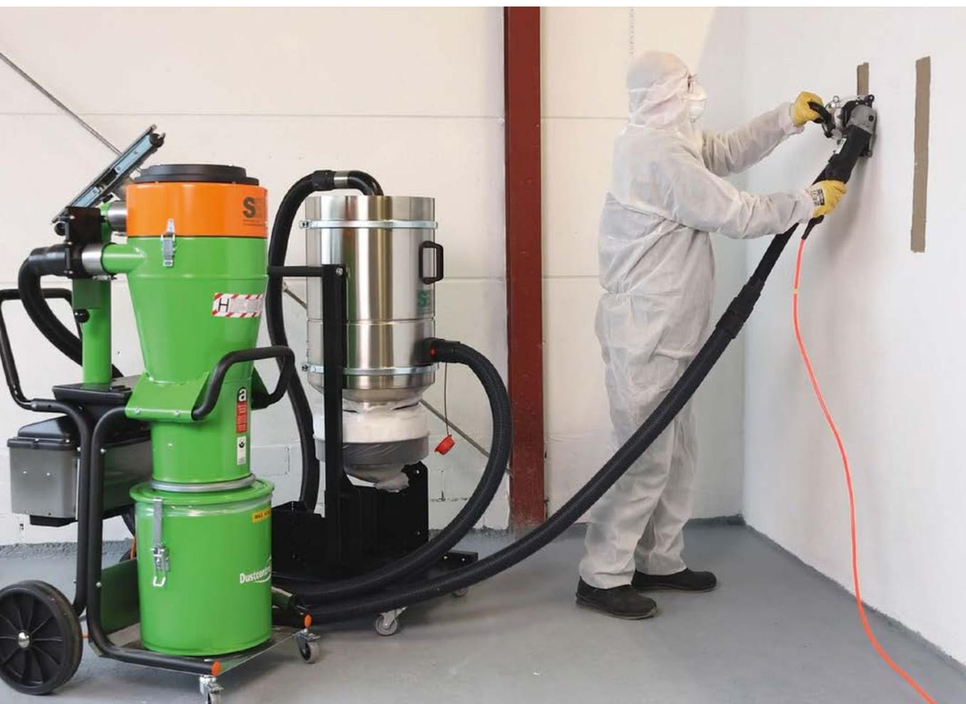
Das Maschinenpaket aus Vorabscheider mit Direktabsaugung und Wandfräse ermöglicht ein sicheres Abtragen von Putzen, Spachtelmassen und Fliesenklebern
