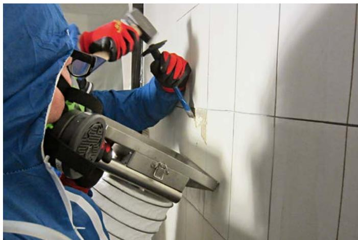
Händisches Entfernen der Fliesen mit Hammer und Meißel unter Absaugen mit dem Trichterabsaugsystem
